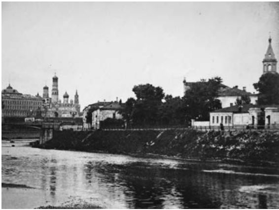
Blick vom Damm auf die Bersenev-Uferstraße
